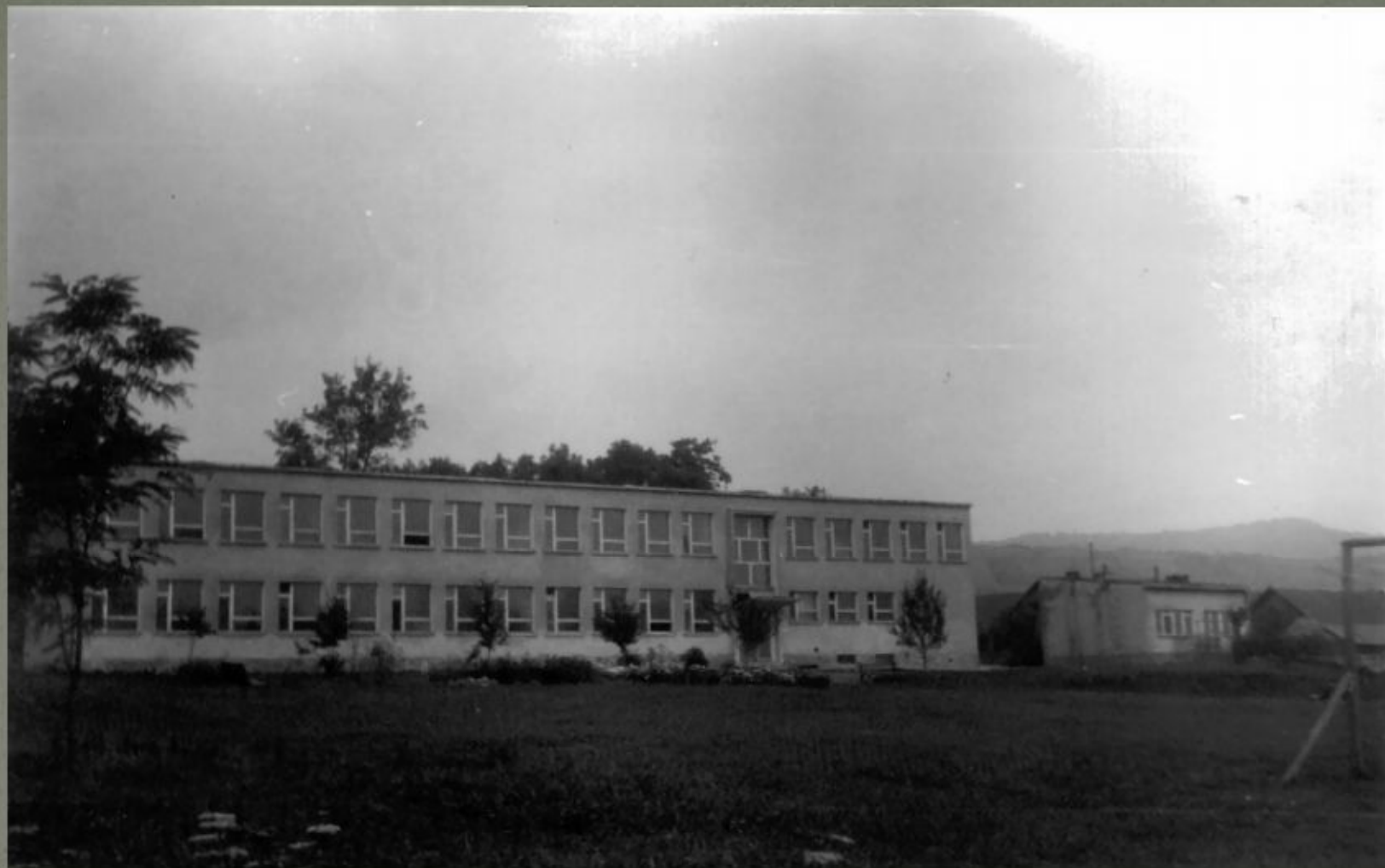
Widok szkoły od strony boiska
