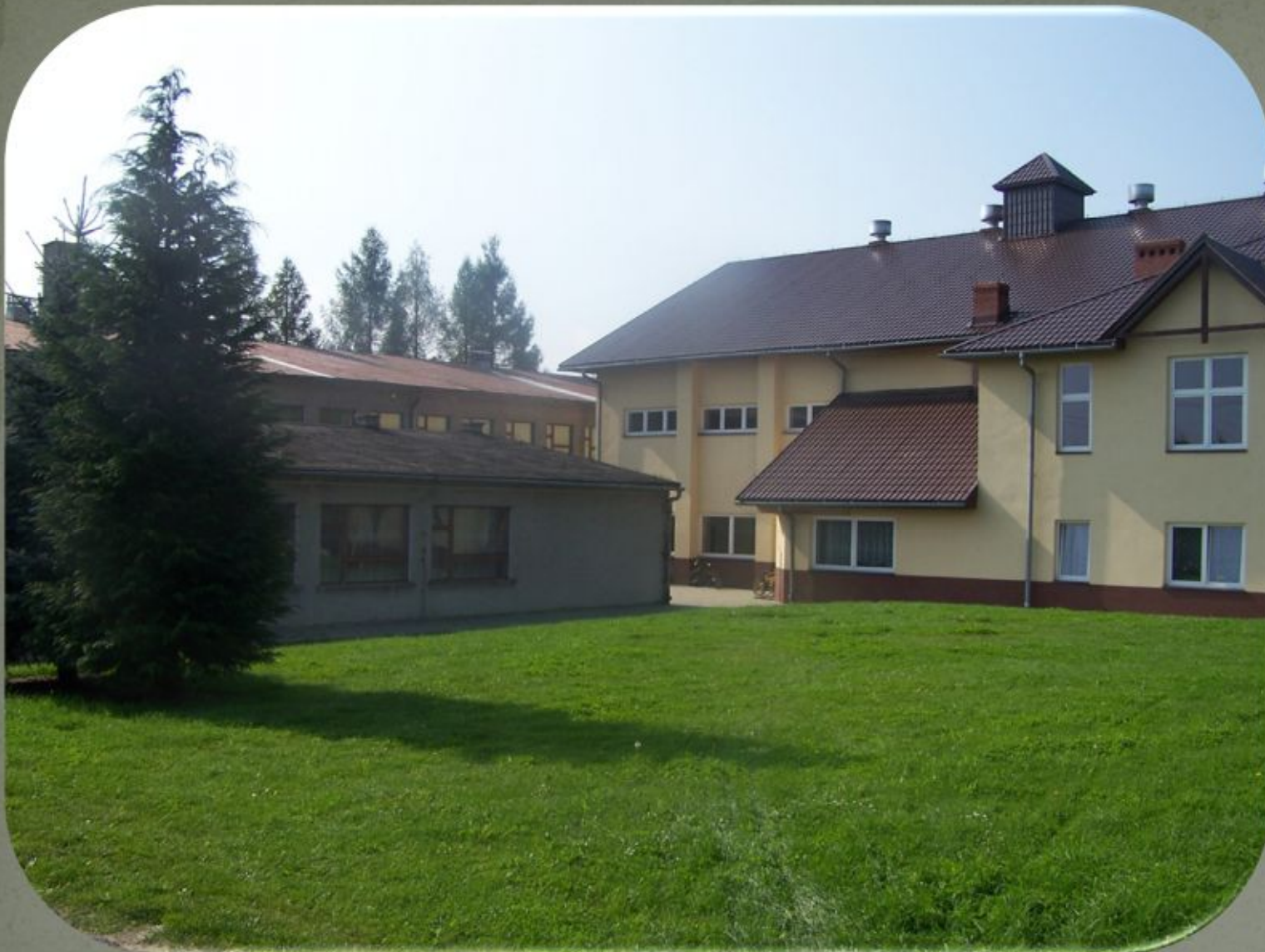
Widok nowej sali gimnastycznej
